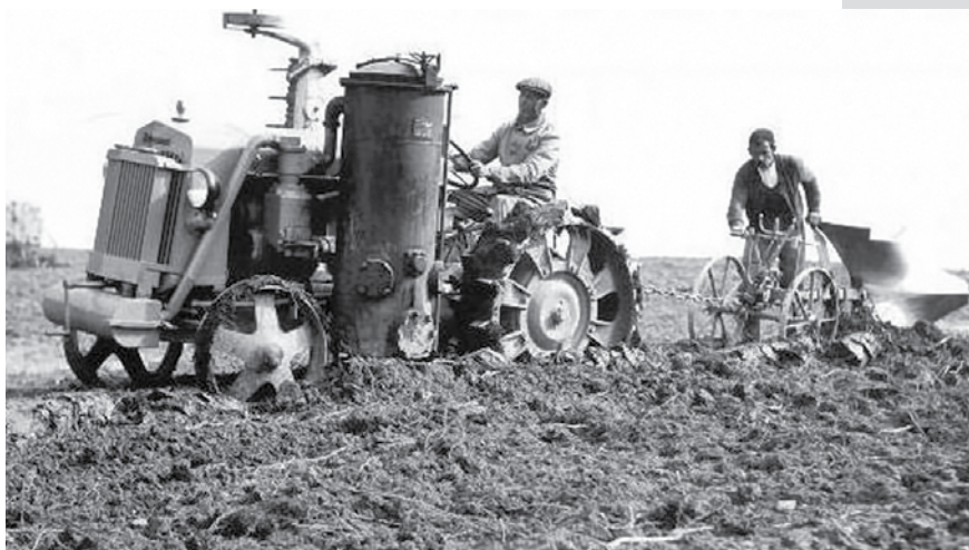
Тракторы 4DKT70, производимые заводом Hürliemann были переделаны с дизеля на дрова главным конструктором Аристэ Льем из-за нехватки нефти во времена Второй мировой войны
